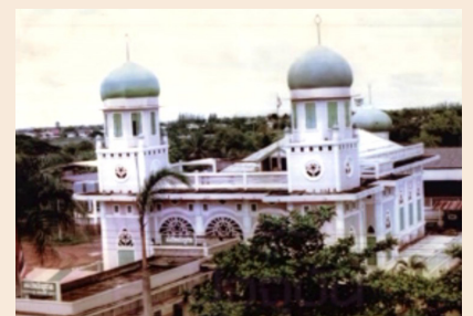
ภาพมัสยิดอัลยุซรอ เป็นอาคารคอนกรีตเสริมเหล็ก อาคารนี้ใช้ทำอิบดะห์มาประมาณ 54 ปี
